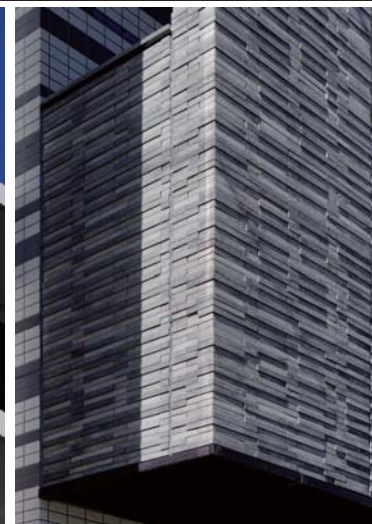
東側外装壁(低層部)
