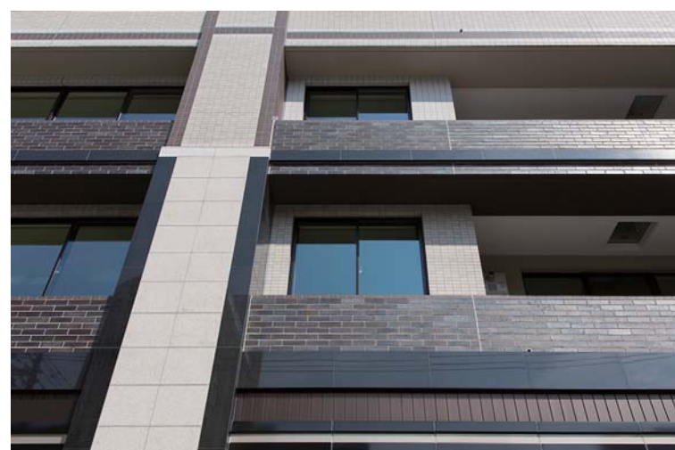
開口部外装壁面
