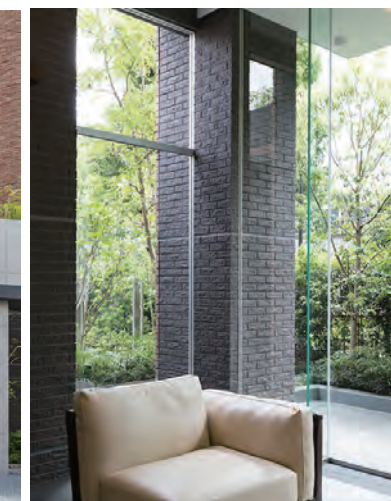
東南角柱廻り
