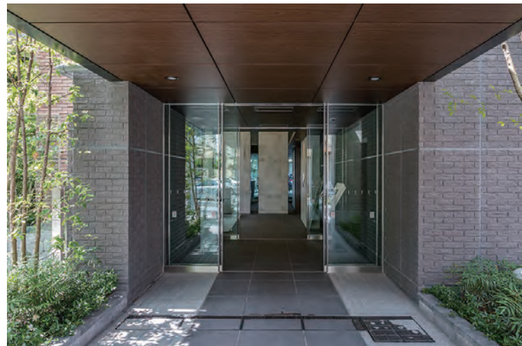
エントランス外観
