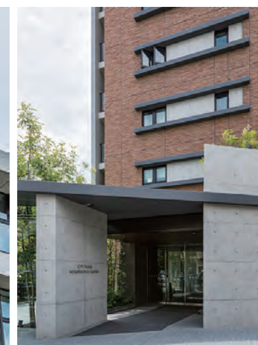
東南側エントランス
