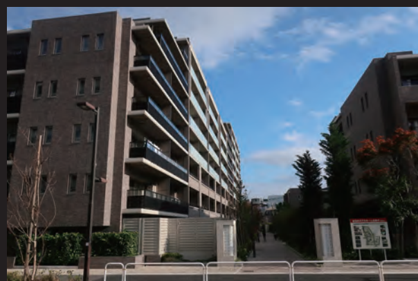
エントランスゲート
