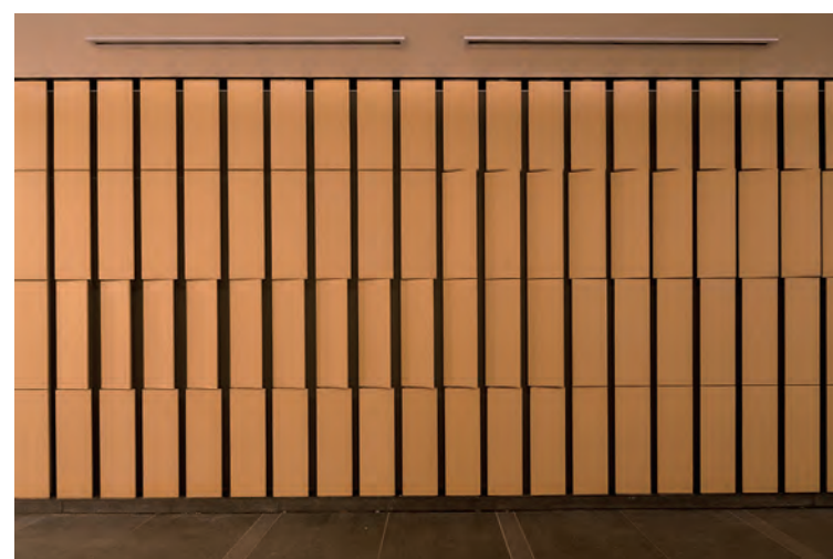
エントランス正面内装壁面
