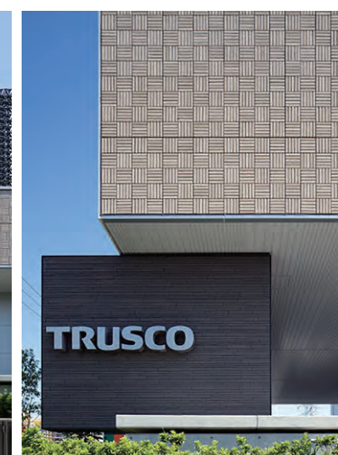
エントランス外装壁
