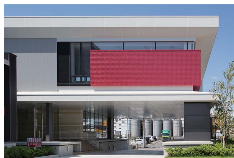
パントリー外装壁
