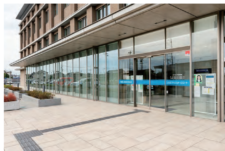
入口外装壁面
