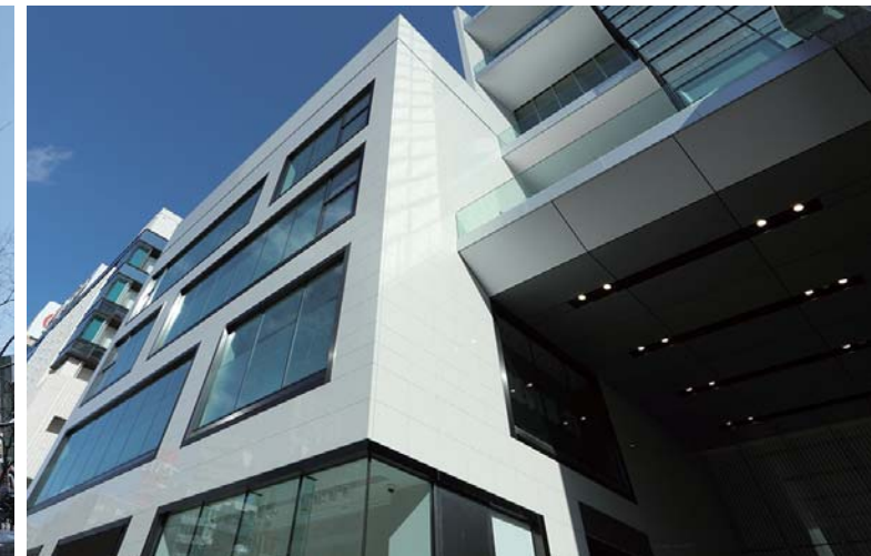
西側外観見上げ
