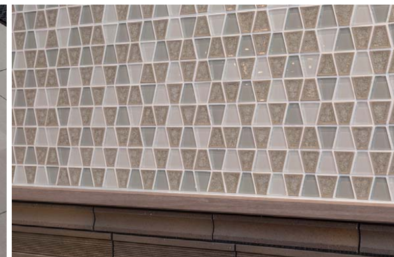
内装壁面ディテール
