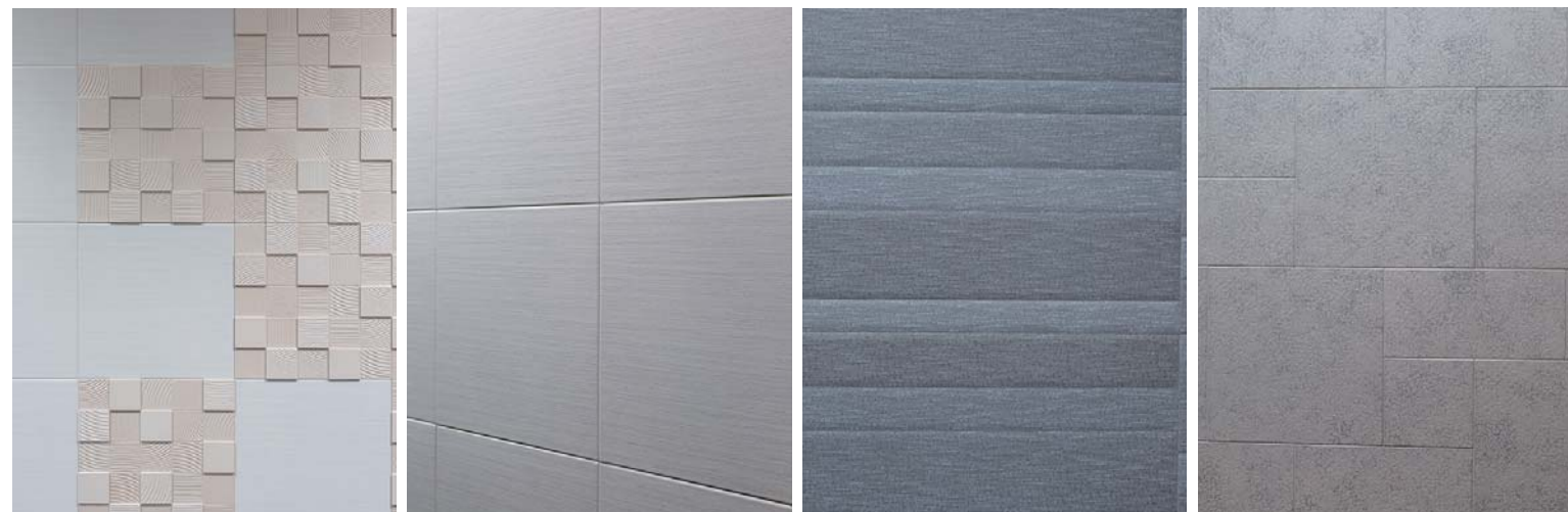
内装壁面ディテール
