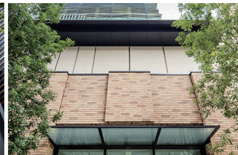
外装壁面(見上げ)
