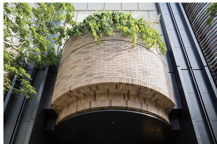
外装壁面(見上げ)
