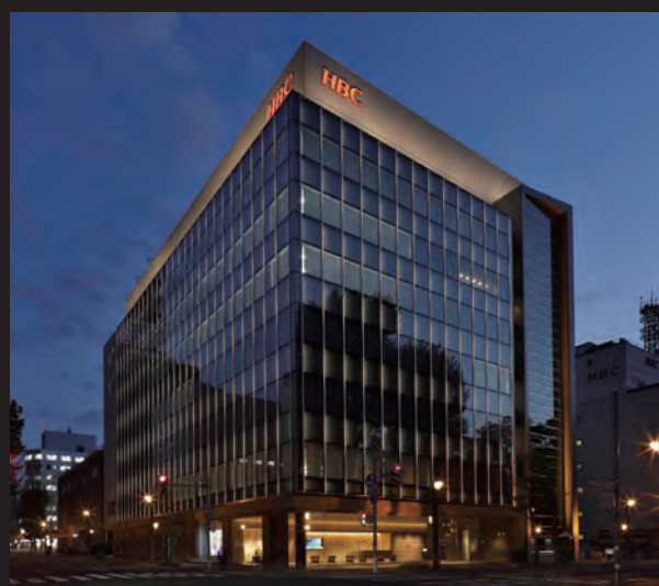
外観全景 (夜間)
