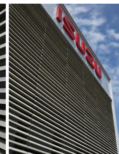
外装壁面(見上げ)
