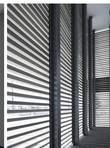
1F部分(内部より)
