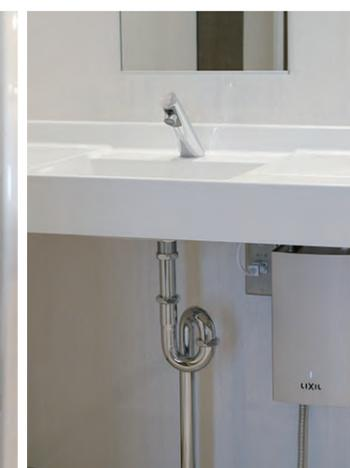
様々な利用者が安心して使えるよう、通路や便器にそれぞれ手すりを設置。壁掛タイプの小便器と尿だれを考慮した汚垂石を設置することで、小便器エリアの床が清掃しやすくなっている。洗面カウンターには、必要ときだけ必要な水温まで瞬間的に加温して供給する加温自動水栓を備え、無理なく節電と節水に貢献している。
