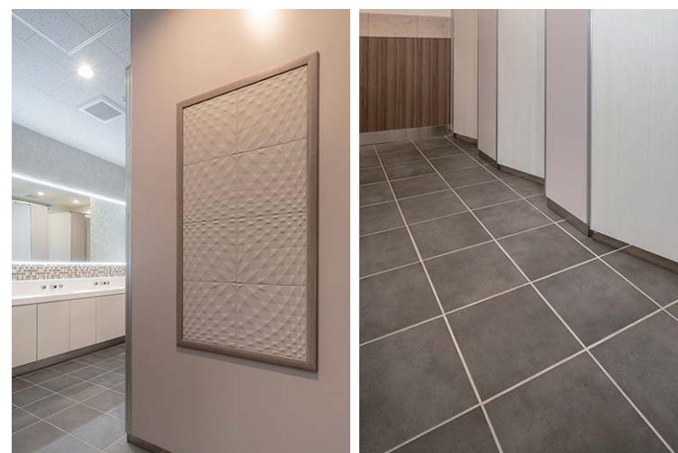
調湿・脱臭機能に優れたエコカラットをアクセントとして設置。室内は淡色の壁から濃色の床へのグラデーションが美しく、落ち着いた中にも柔らかい印象を感じさせる。
