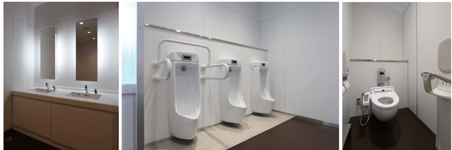
乳幼児連れの利用者に配慮して、男性用トイレにもベビーキープを設置。自動水栓やセンサー感知による自動洗浄ボタンの採用で節水につなげている。
