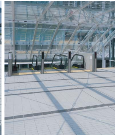
エスカレーター前(2階部)
