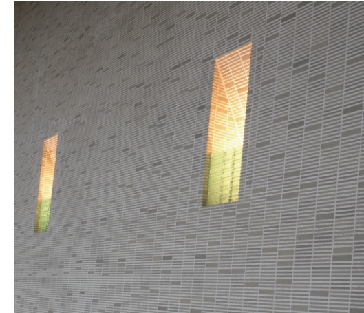
北東側開口部近景
