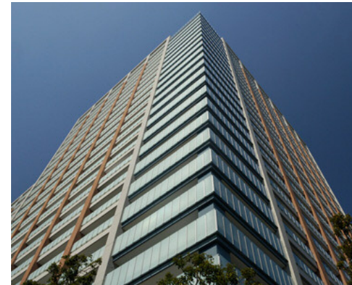
南東側見上げ
