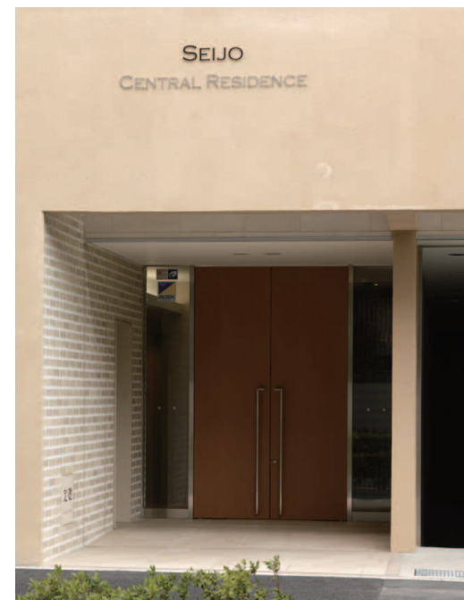
西側エントランス
