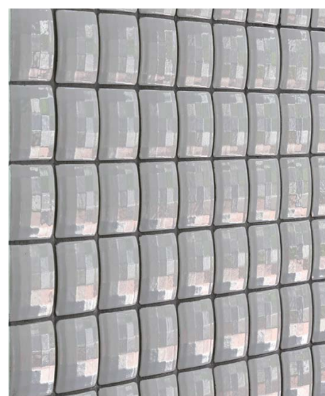
エントランスホール内壁
