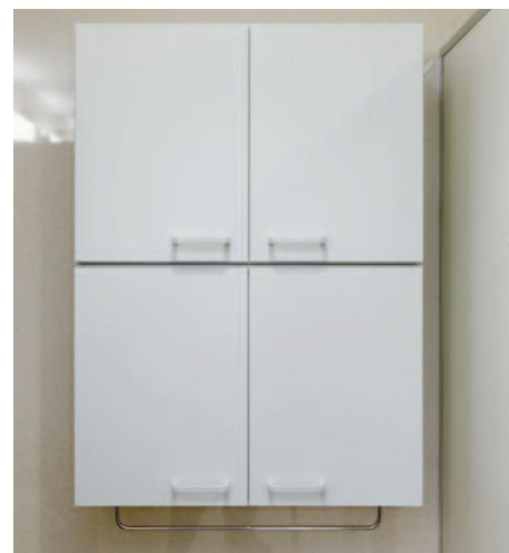
女性用トイレ内に設置。
