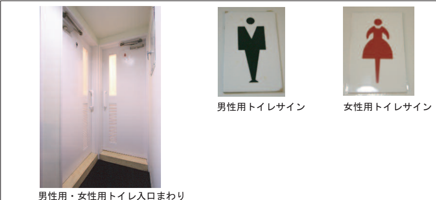
男性用・女性用トイレ入口まわり
