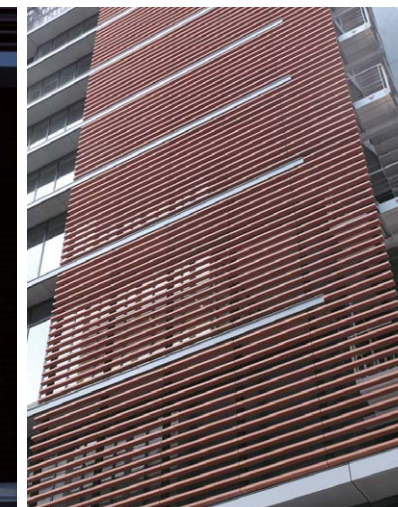
ファサード見上げ中景
