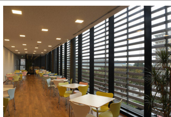
食堂からテラコッタルーバーを見る
