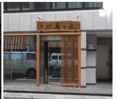
1階店舗ファサード
