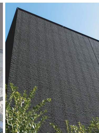
外装壁見上げ
