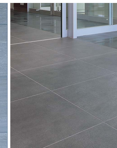
東側玄関内装床
