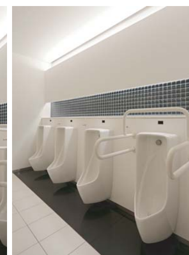
スーパーAI節水機能を備えたセンサー式自動洗浄壁掛式小便器と、超節水ECO6のパブリック向け大便器で、大幅節水に貢献するオフィスに。小便器は壁掛式のため便器下の汚れやすい床面を簡単に掃除することができ、オフィストイレに望まれる清潔な空間を維持しやすくなっている。壁面に使用されたアクセントタイルの光沢も清潔感の演出に貢献。
