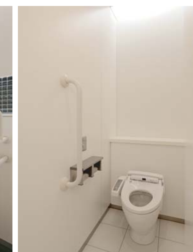
スーパーAI節水機能を備えたセンサー式自動洗浄壁掛式小便器と、超節水ECO6のパブリック向け大便器で、大幅節水に貢献するオフィスに。小便器は壁掛式のため便器下の汚れやすい床面を簡単に掃除することができ、オフィストイレに望まれる清潔な空間を維持しやすくなっている。壁面に使用されたアクセントタイルの光沢も清潔感の演出に貢献。
