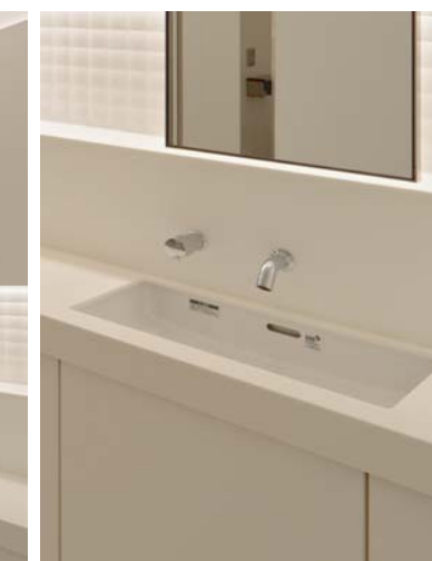
手洗いコーナーとパウダーコーナーがL字に配置された女性用トイレ。水栓はカウンターまわりが汚れにくく、水の止め忘れも防げる衛生的で経済的な自動水栓を採用。個室間の仕切りは天井まで立ち上げられており、利用者同士のプライバシーに配慮。また、横ラインの間接照明やアクセントのパール調タイルも空間に広さと明るさを演出している。
