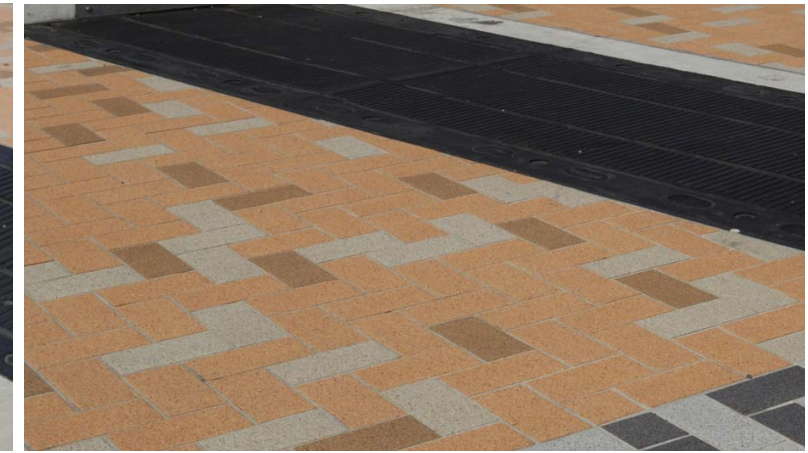
排水溝まわり
