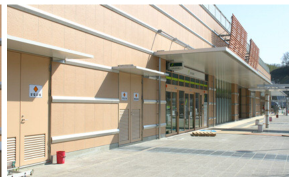
駅舎外観全景
