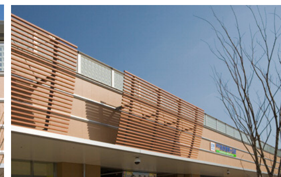
駅舎外観全景
