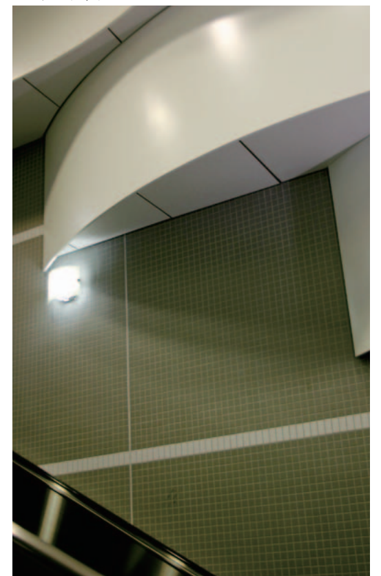
ホーム階段 壁面
