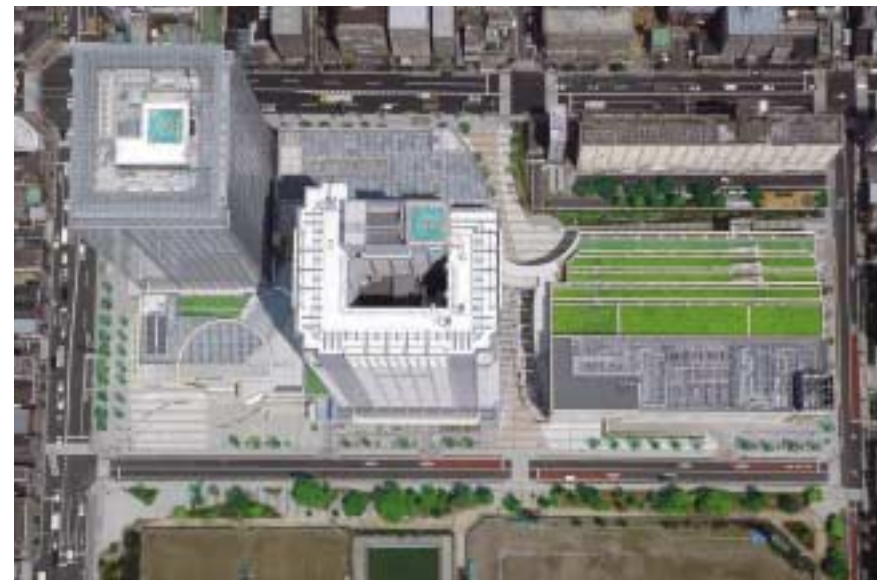
「olinas(オリナス)」空撮(写真:三輪晃久写真研究所)
