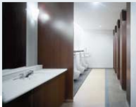
基準階男子トイレ ●INAX使用商品●小便器：HU-AWU506RP、洗面器：HU-L2094AM
