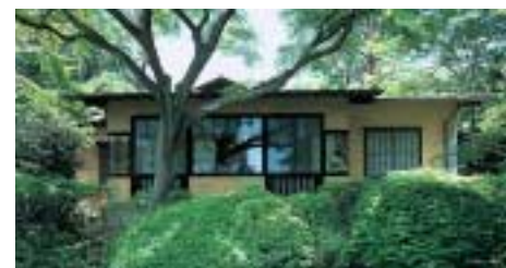
左—縁側のコーナーサッシュー 夏は熱を遮断、冬は熱を家に取り込むサンルームとなる縁側のサッシューは、風景を取り込むために軒を枯木（はねぎ）で持たせ柱をなくしている。特にコーナーサッシューは、嵌殺しガラスの突き合せ部分の方立ての見付を極限まで小さなもの（斜め方向で20mm）にしている 右—南面全景 デザイン的にも環境工学的にも「聴竹居」の顔となる部分である。日射調整を兼ね、水平に、軽やかに伸びた銅板平葺きの庇と、透明感のある縁側の連窓。裏面には屋根裏の換気口と、縁側の足元には通風用の小窓。更に土台部分には床下換気口とともに部分的に自然石を埋め込み、周辺の自然との一体感を図っている（2005年撮影）
