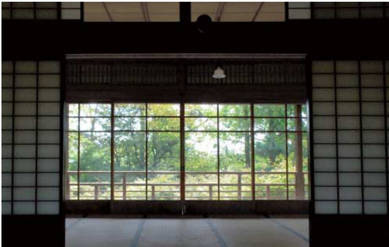
縁側 1階の大広間の南側には、自然豊かな庭越しに遠く大阪湾を望む縁側が設けられている。畳に座った位置から風景を十分に堪能できるよう横棧を減らしたサッシに、当時としてはとても大きなガラスがはめ込まれている
