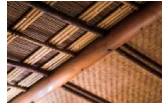
「聴竹居内閑室」 “閑室”と名が付けられた藤井の書斎兼接客空間 上—天井部分 竹皮の網代、萩、竹、皮付丸太を巧みに組み合わせた饒舌な天井ディテール。和紙貼りのすっきりとした「聴竹居」の天井とは対照的 中—上段の間 下段の間より30cmほど上がった畳敷き。下段の間の腰掛と緩やかに仕切る円弧状の開口は、椅子座と床座の連続性を生み出している 下—下段の間 コーナーサッシューのところに造付けの革張りの腰掛があり、コーナー部分には違い棚に似た小さな飾り棚が設けられている
