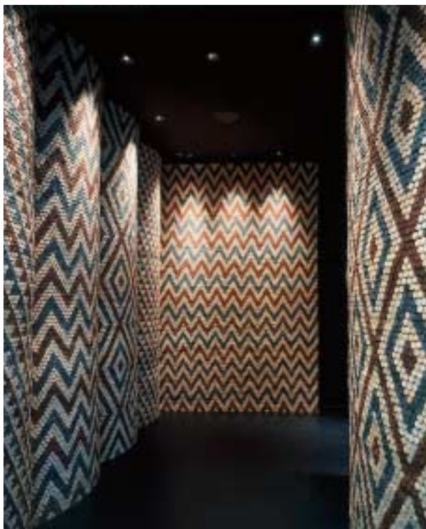
長さ10cmの円錐形のやきものである。円錐形は施工して始めて大きな意味があることに気付いた。円柱は円錐形でなければ施工できない
