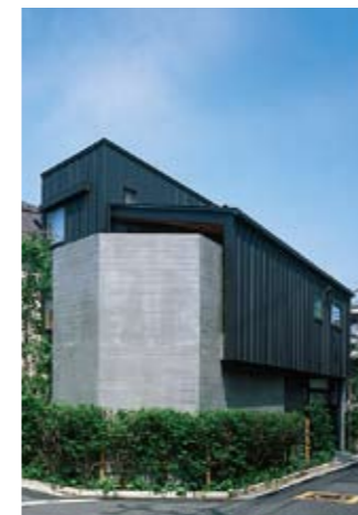
南東の角から見上げた外観。コンクリート打放しの音楽室をガルバリウム鋼板の屋根と壁が覆う。まるでひな鳥をかばう親鳥の翼のよう
