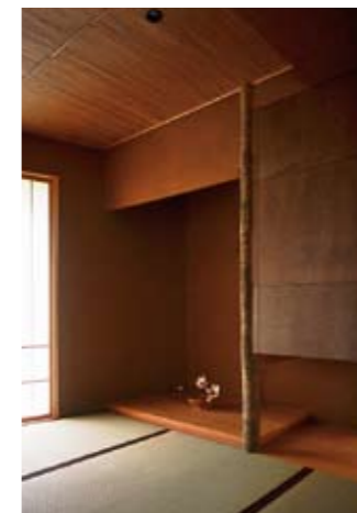
泉さんが腕によりをかけたとおぼしき凝った造りの和室。壁は錆土水捏ね仕上げ。床板と吊り押し入れ下の地板は唐松の一枚板で「高かったぞう〜」
