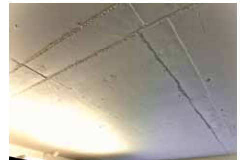
天井はコンクリートスラブをあらわしにして、白く塗装してある。ペニヤ型枠のランダムな継ぎ目が、韓紙の重ね目のほつれのように、素晴らしい
