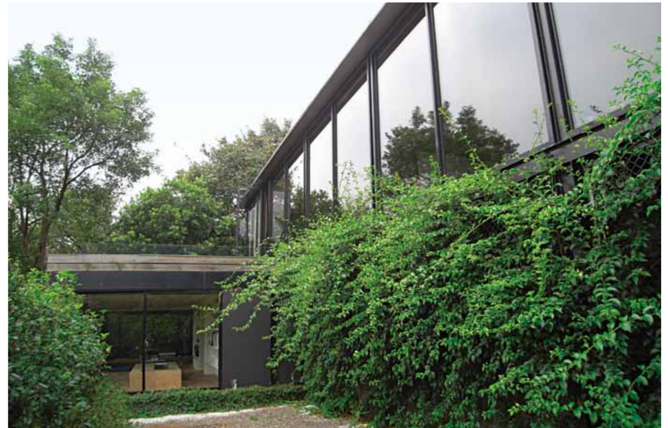
下の階の地上から縁に包まれた「陽明山のすまい」を見上げる。下階の屋根は広々としたルーフトラスになっている
