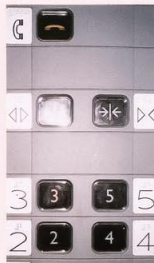
エレベーターのボタンの横に大きな文字と点字が表記されている
