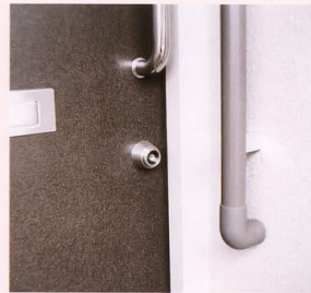
ドアを開け閉めしやすいようにサポート用のざり棒をつけ、鍵穴もすり鉢状にしている
