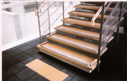
階段の踏み面には杖が流れないよう工夫がされている
