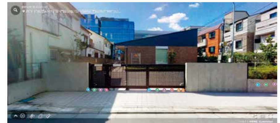
【図3】引戸門扉の施工事例。車椅子を想定した設置方法など、詳細な施工ポイントも確認できる
