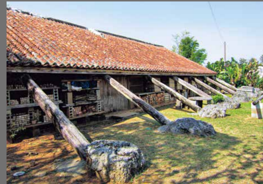
使用済み木製電柱のバットレスが石灰岩の礎石に接続された外観（左）および販売所の内観（右上）。小屋組みにも電柱が用いられている。屋外に突き出した登り梁と横架材のディテール（右下）【写真：黒岩構造設計事務所】
