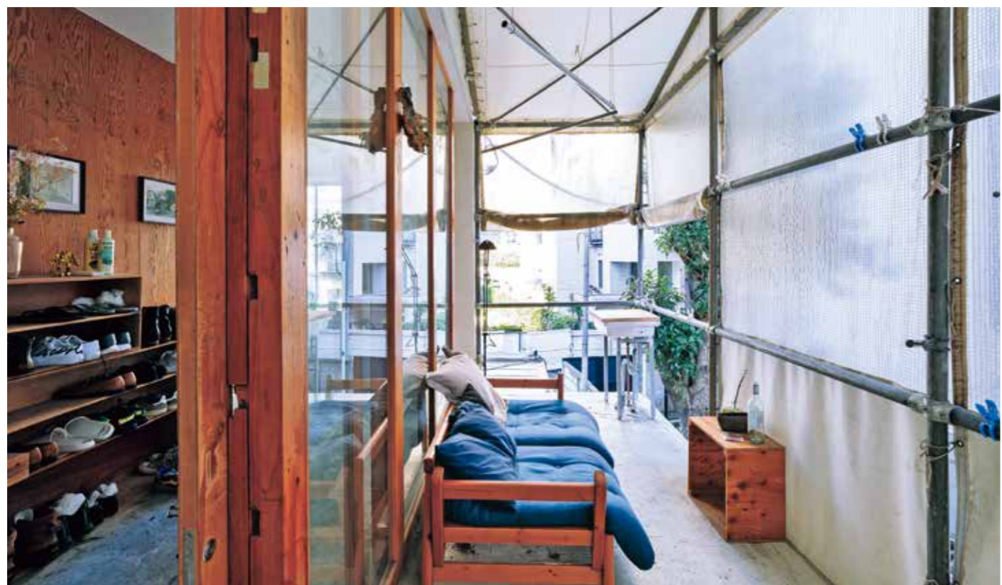
前庭の外階段を上った2階は、既存のバルコニーを利用したエントランス空間。バルコニーに開閉式のテント幕を張り、プライバシーの度合いを調整できるようにした
