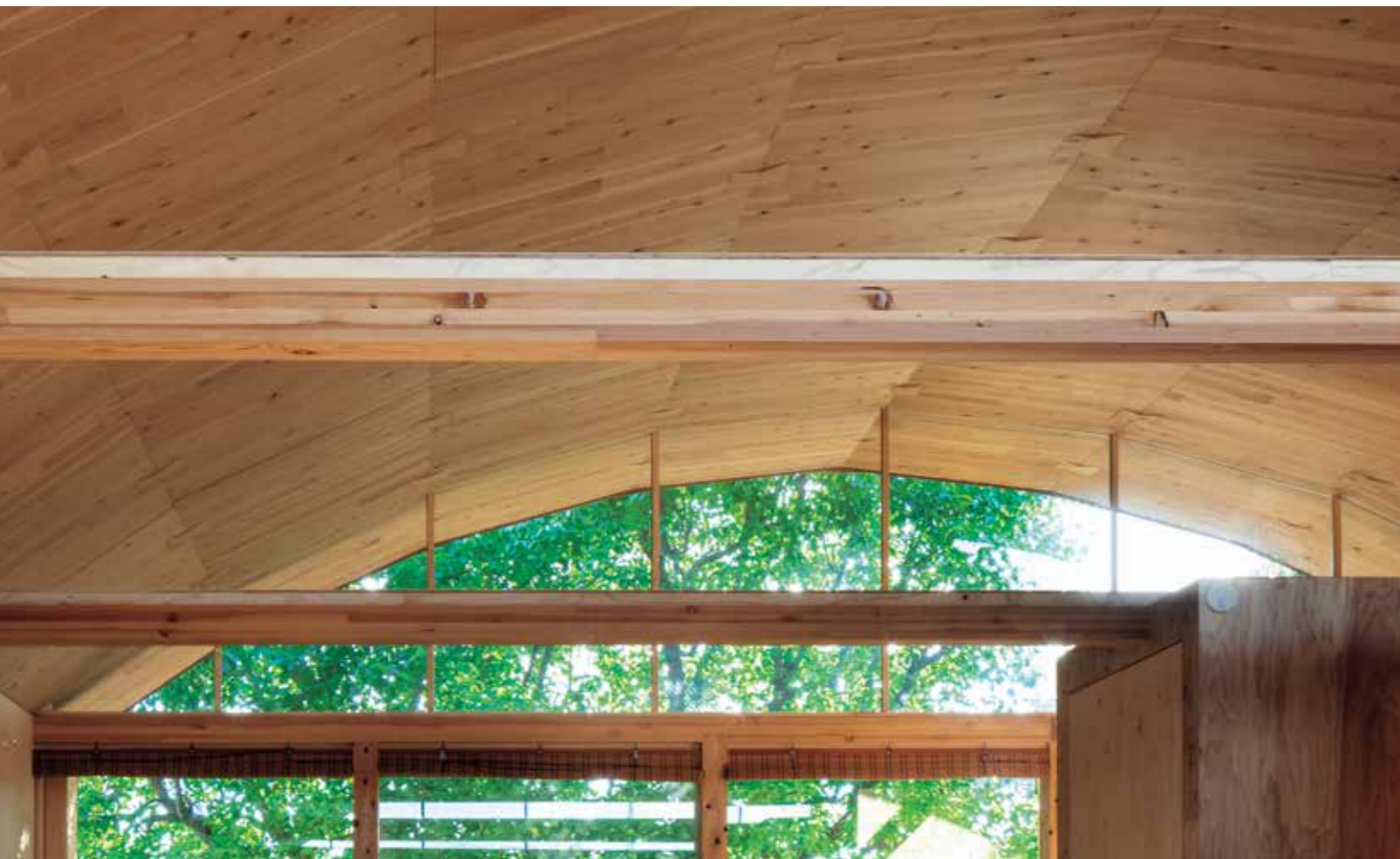
CLTの組積アーチで覆われた神水公衆浴場の2階ダイニング。アーチはCLTの接合部に千切りを打ち込んで継いだ嵌合接合で構成される [写真：小川重雄]
