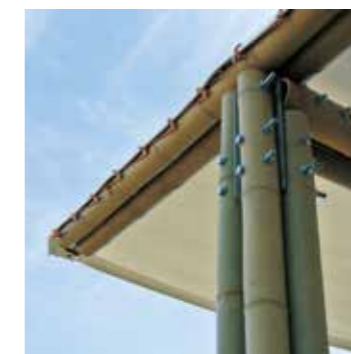
2022年に九州大学岩元真明研究室と共同制作した竹の仮設架構「那珂川プロジェクト」の接合部。竹をプレートにボルト留める方法を採用した [写真: 岩元真明研究室]
