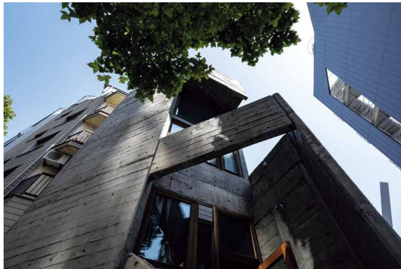
前面道路からの見上げ。壁梁をまわしたり、庇の先を下がり壁にしたりして、外部空間を内側に囲い込んでいる
